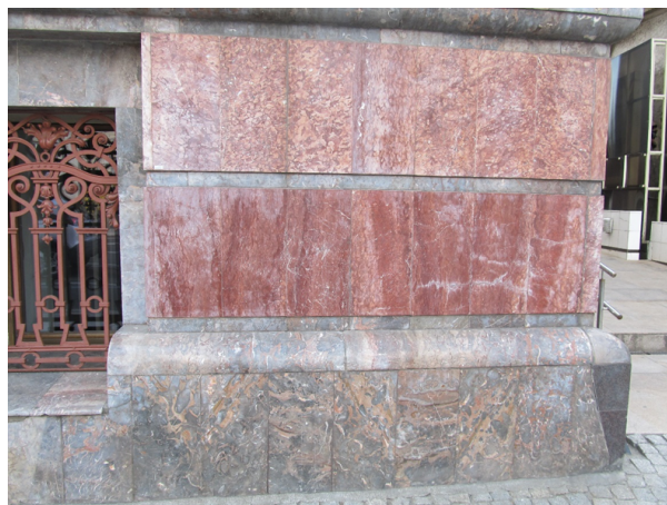
Fig. 4 Calcar de Moneasa folosit pentru placare exterioară, fațada rectoratului Universității Tehnice din Cluj Napoca
